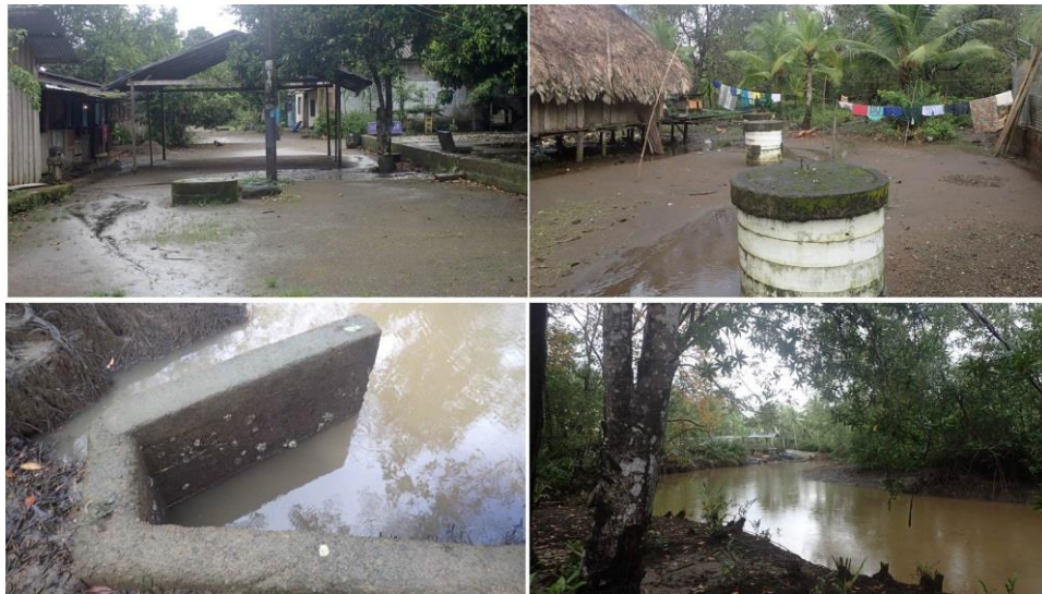
Figura 1.38. Sistema de alcantarillado para la recolección de aguas residuales de la población en Panguí, y vertimiento en el estero Coquí. Fotos: Ostín Garcés.
